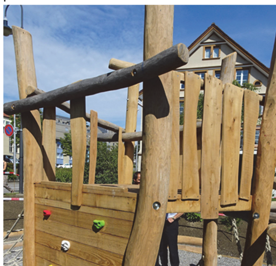
Abbildung 9 Spielgerät mit Geländer und Brüstungen
